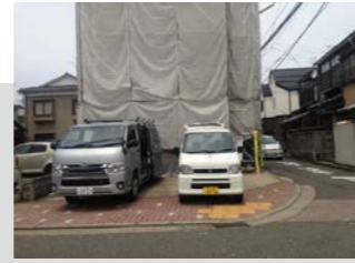
工事中・民家
