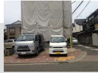
工事中・民家
