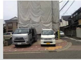
工事中・民家
